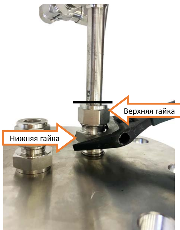
Рисунок 11 – Крепление на резервуаре
